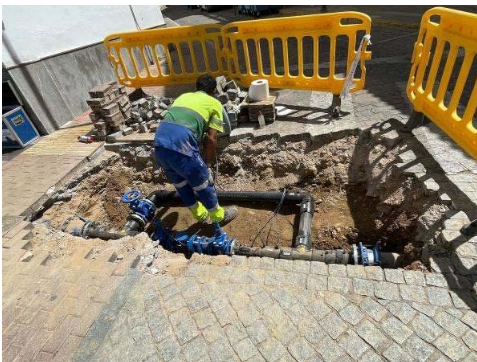
Trabajos en la red
